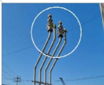
[화염방지장치 및 대기밸브 부착 통기관]
